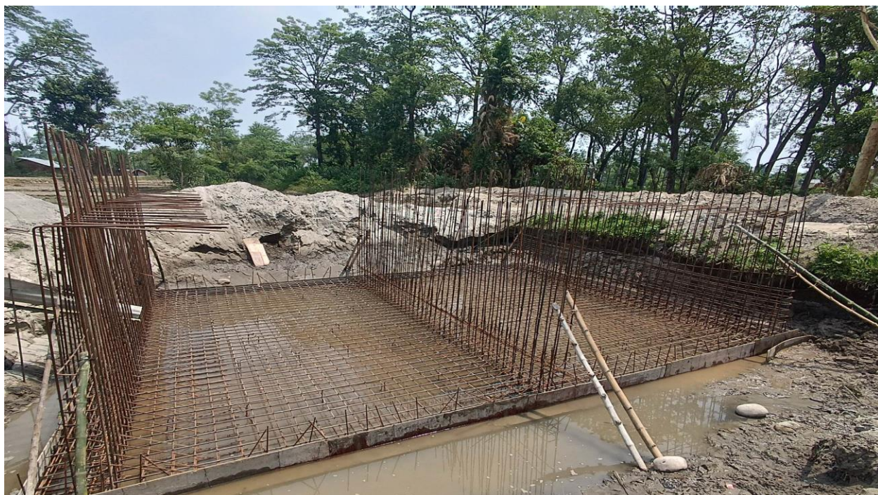
गेरुवा गा पा वडा न ५ र ६ (सोनाहाफाट-स्याउलिबजार ) जोड्ने निर्माणाधीन पुल
