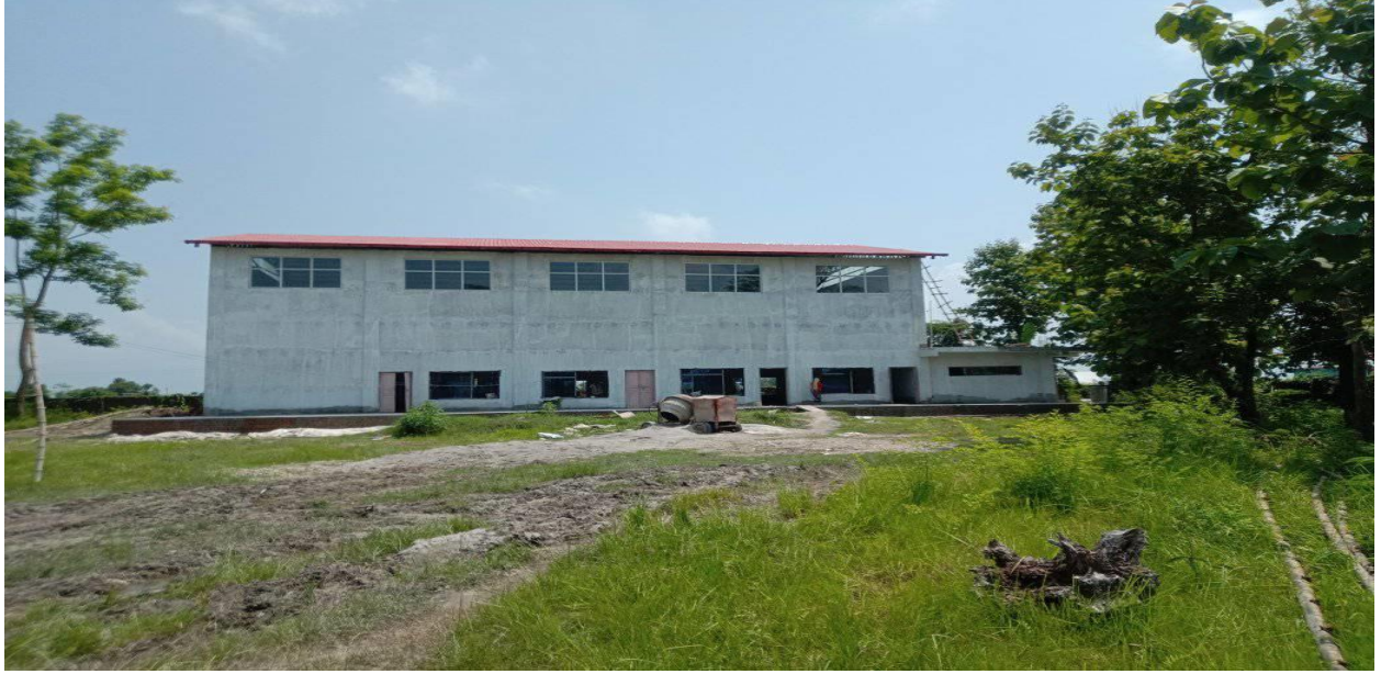
गेरुवा गा पा वडा न २ एकप्रिय राठोर मा बि मा निर्माणाधीन सभाहल
