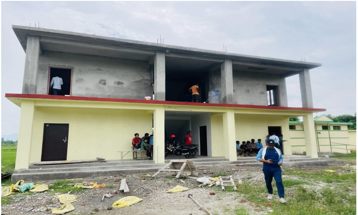
गेरुवा गा पा वडा न ४ सरस्वती आ बि जोधिपुर मा निर्माणाधीन ४ कोठे बिद्यालय भवन
