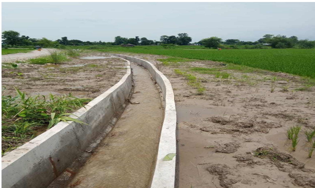
गेरुवा गा पा वडा न ३ बनकट्टी देखि सनकट्टी जाने बाटो मा निर्माण गरिएको पक्कि कुलो
