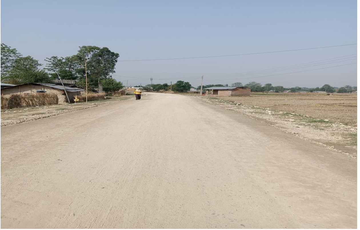
गेरुवा गा पा वडा न १ बिहानिबजार स्थित निर्माणाधीन कालोपत्रे सडक
