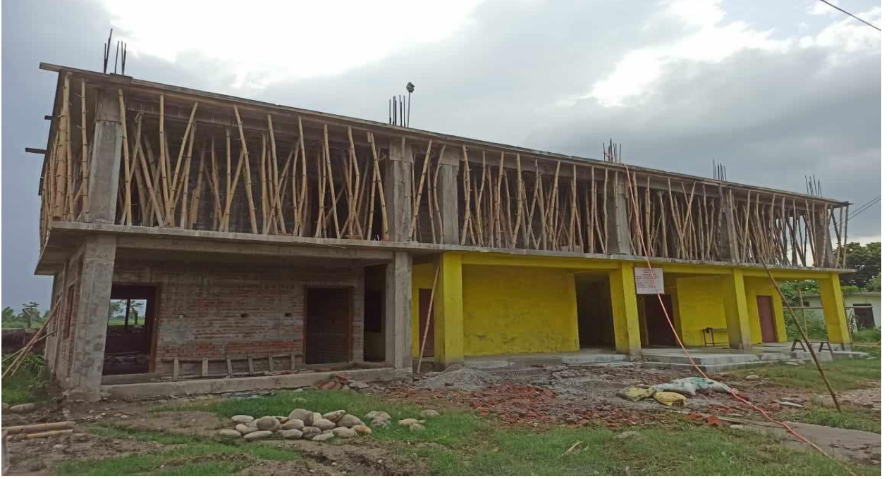
गेरुवा गा पा वडा न ५ पशुपति मा बि मा निर्माणधीन ४ कोठे बिधालय भवन
